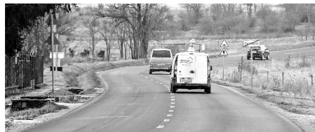
Zalahalápnál is megújult egy jelentős szakasz
